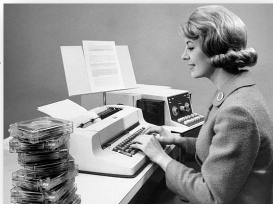
1964. La IBM Selectric, già modello di grande successo, viene dotata di cartucce di nastro magnetico da 16mm, in grado di contenere fino a 25KB di dattiloscritto.
